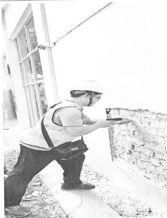
照片 2：现场检测照片
