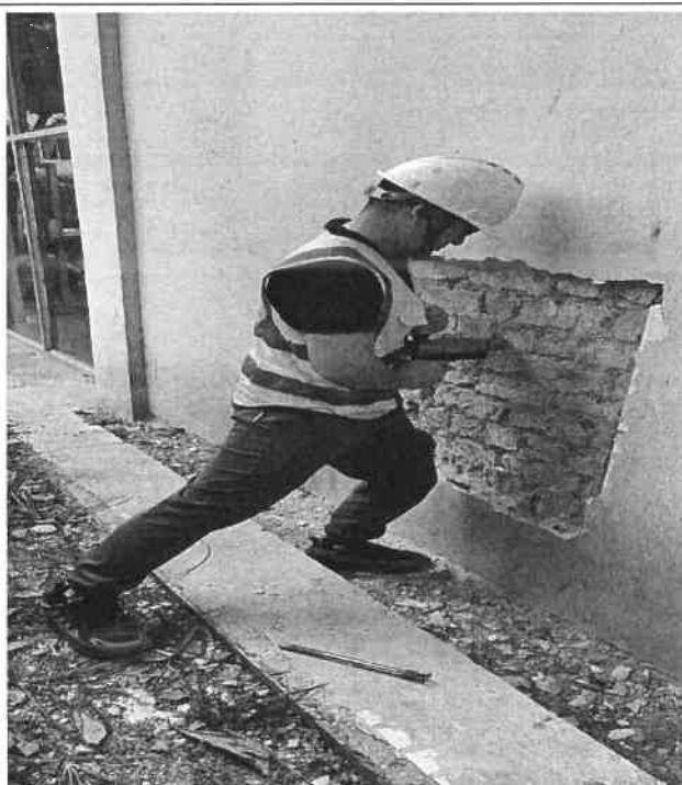
照片 2：现场检测照片
