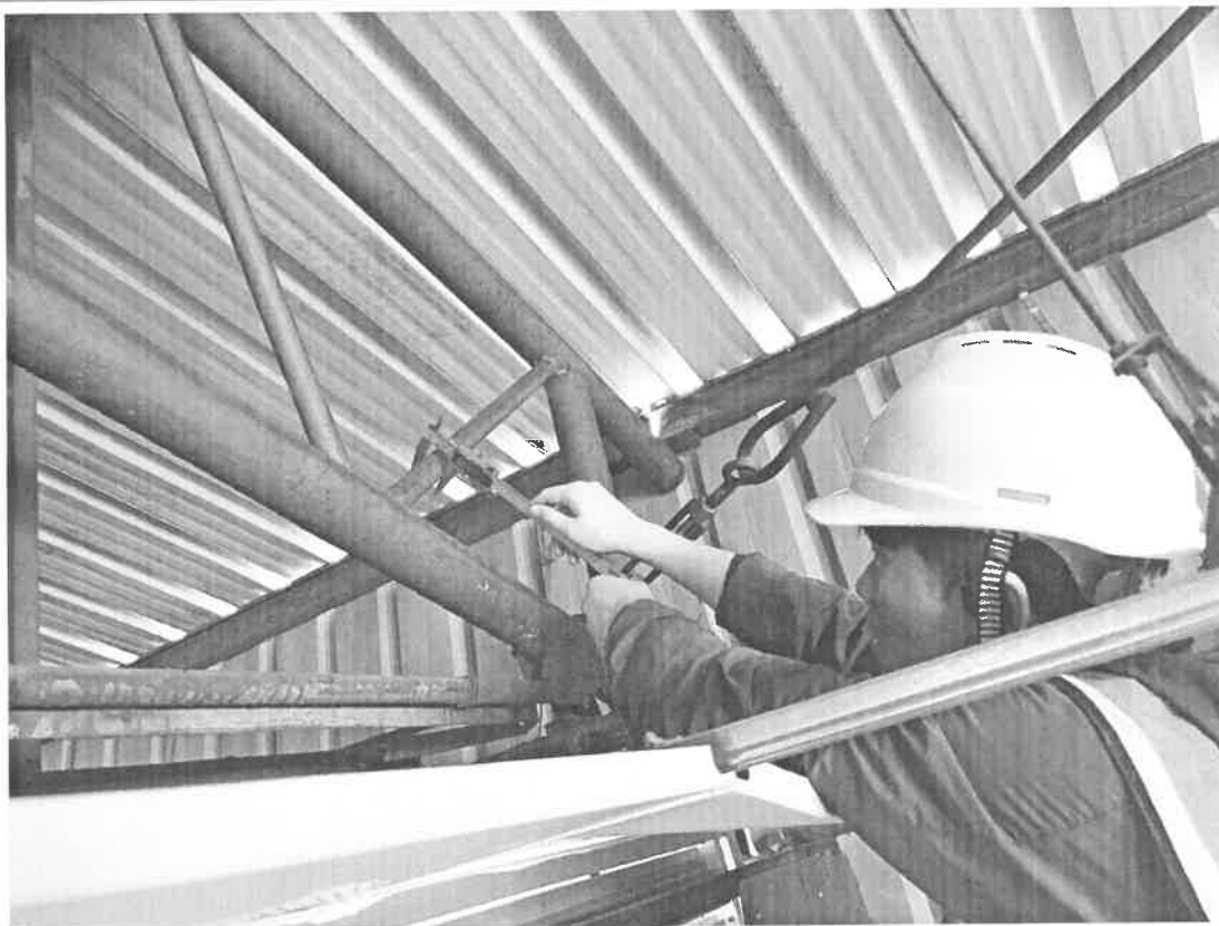
照片 6: 现场检测照片
