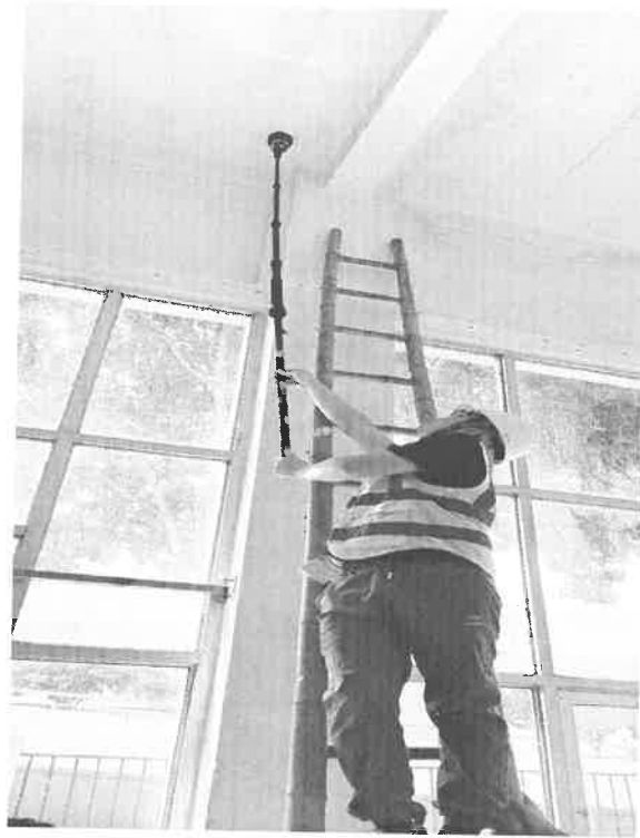
照片 3: 现场检测照片
