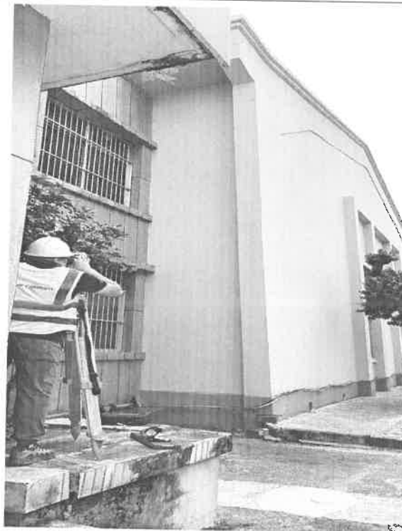
照片 4: 现场检测照片
