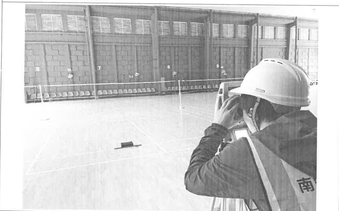
照片 4: 现场检测照片
