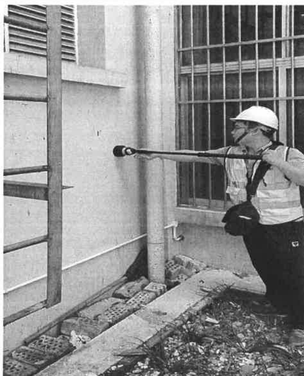
照片 3: 现场检测照片
