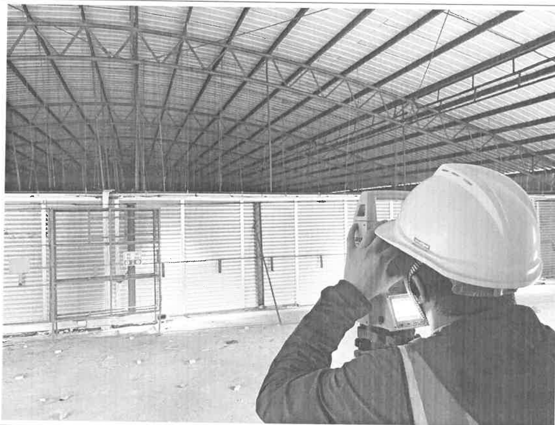
照片 8: 现场检测照片
