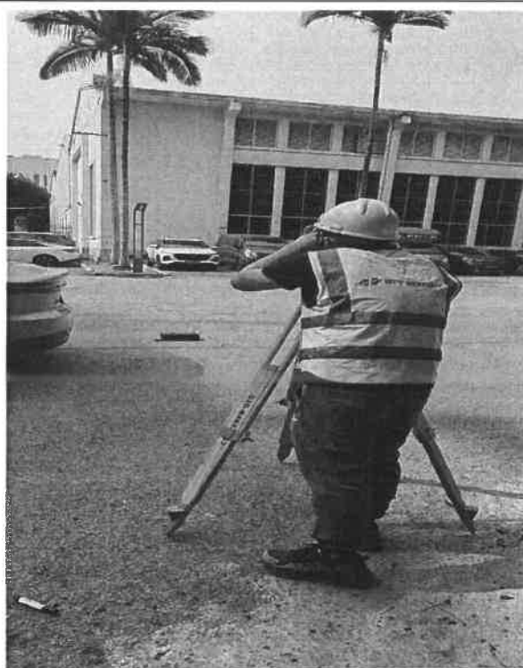
照片 4: 现场检测照片
