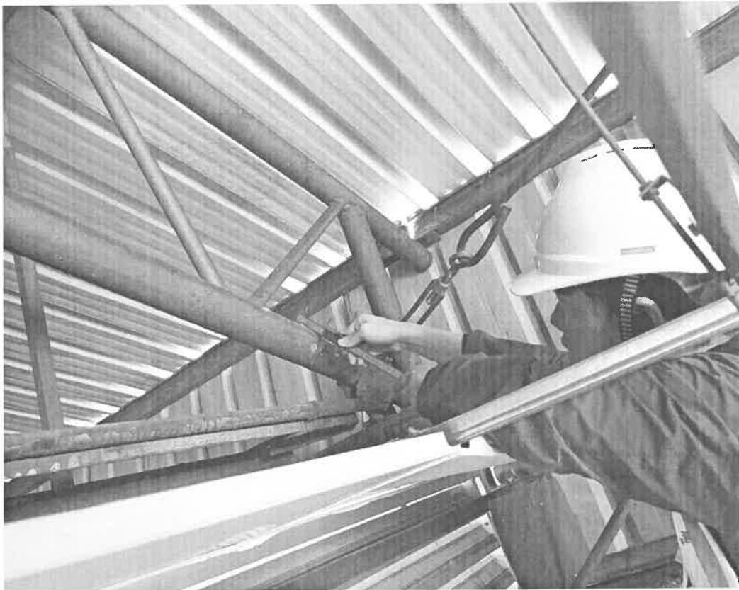
照片 5: 现场检测照片
